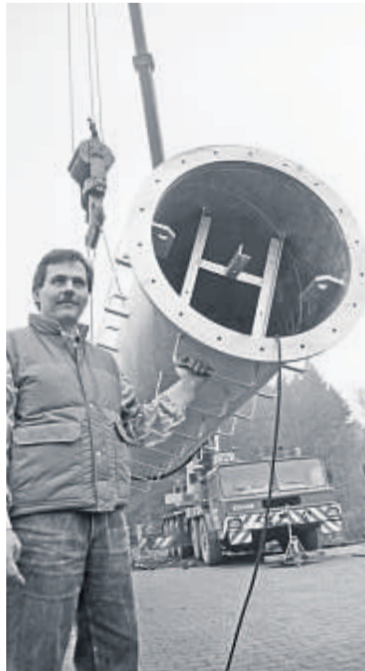
Am 6. Dezember 1989 wurden die ersten Teile montiert.
